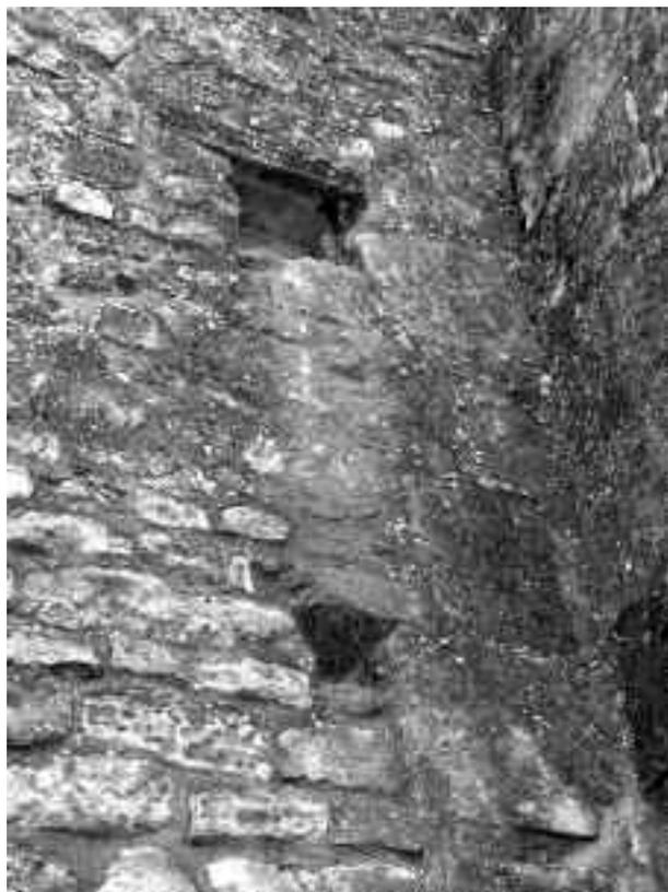
Fig. 29 : Mur gouttereau nord : blocs de chaînage du contrefort occidental et trous de boulins maçonnés et façonnés (cliché de l'auteur)
