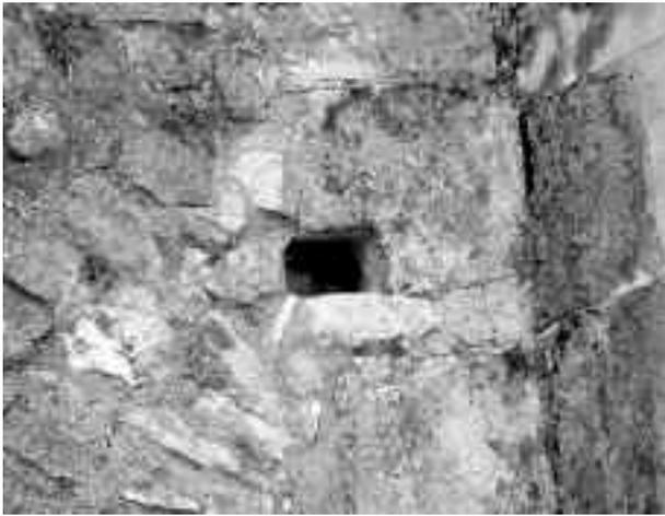
Fig. 30 : Mur gouttereau nord : trou de boulin aménagé à la fois dans les moellons du mur et dans un bloc de chaînage du contrefort médian (cliché de l'auteur)
